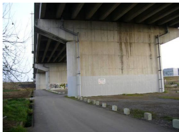
美合橋 橋脚 落書き防止塗装
