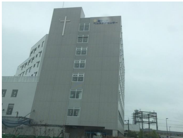
聖マリアヘルスセンター 新築工事
