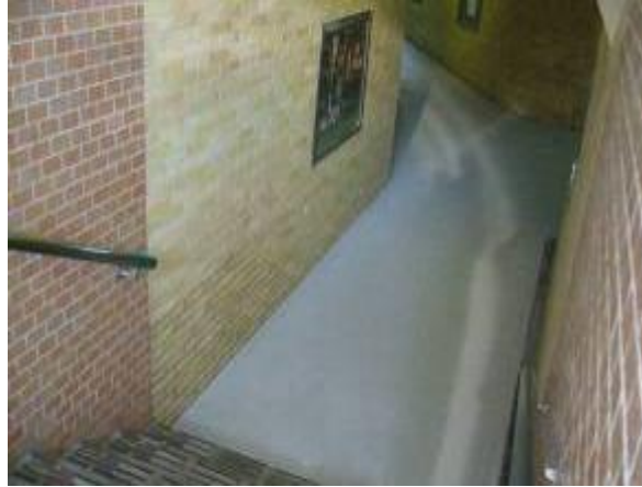
地下道 防臭・清掃メンテナンス軽減施工
