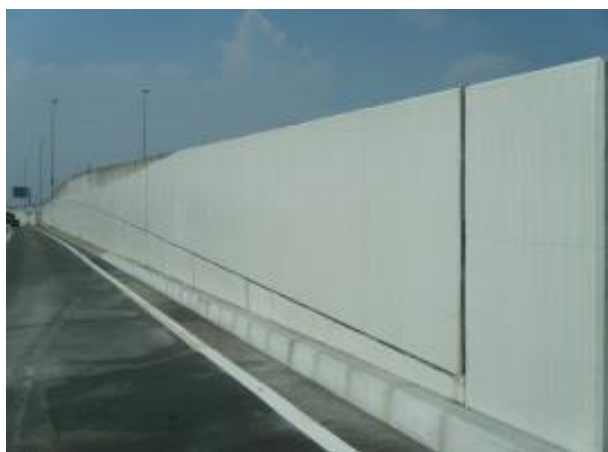
国道23号線 擁壁 落書き防止塗装
