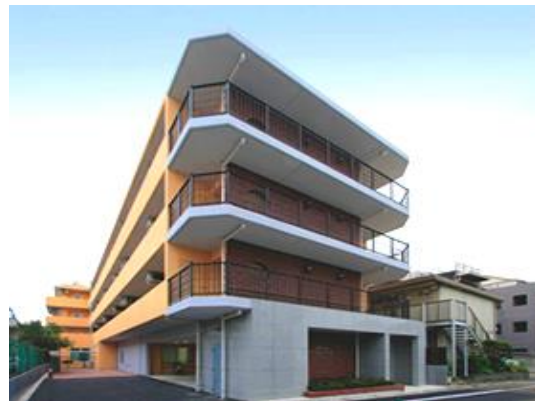
ファミニュー大森南新築工事
